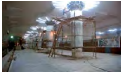
Рис. 55.3. Станція метро «Олексіївська»
