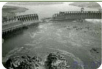
Іл. 45.8. Зруйнована вибухом гребля Дніпрогесу в 1941 р.
