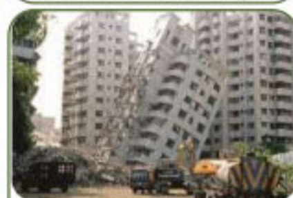
Іл. 45.15. Наслідки землетрусу
