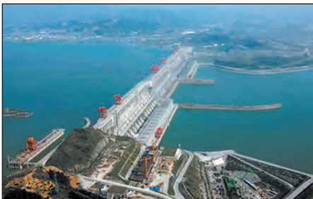
Мал. 1. ГЕС «Три ущелини» на річці Янцзи (Китай) — найпотужніша у світі (22,4 ГВт). Протяжність греблі — 2,3 км, висота — 182 м. Під час будівництва ГЕС було затоплено 13 міст та переселено 1,3 млн осіб.
