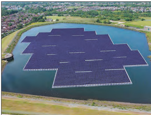
Мал. 1. Найбільша у світі плавуча сонячна електростанція в Хуайнані (Китай). 160 тис. сонячних панелей розташовані на водній поверхні площею майже 90 га (територія середнього села). Перевагами таких електростанцій є те, що вони не займають багато місця, а вода діє як природний охолоджувач, що збільшує обсяги виробництва електроенергії.
