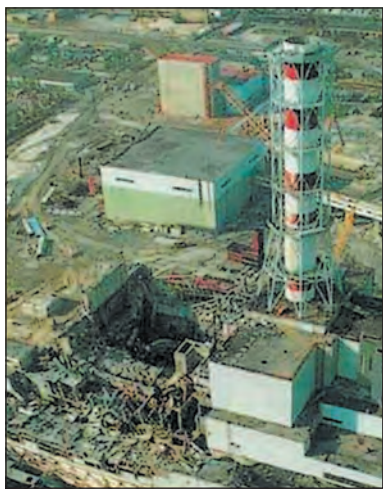
Зруйнований 4-й енергоблок Чорнобильської АЕС. 1986 р.
