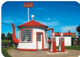
Автозаправна станція. США
